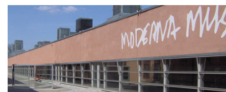
Edificio del Museo de Arte Moderno de Estocolmo (Moderna Museet), diseñado por el arquitecto español Rafael Moneo y ubicado en la isla de Skeppsholmen (Estocolmo, Suecia).
